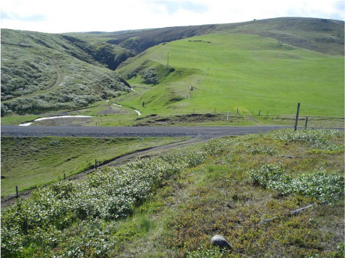
Mynd 3. Staðsetning stöðvarhúss (sem er inni í fjallinu). Munní aðkomuganga verður ofarlega til hægri í grænu brekkunni og munní frárennslisganga neðan við rafmagnsstaurn fyrir miðri mynd. Frárennslisskurðurinn verður í beinni línu frá munna frárennslisganga að manningum sem stendur við lækinn. Ljós. Steinar Ingimar Halldórsson.
